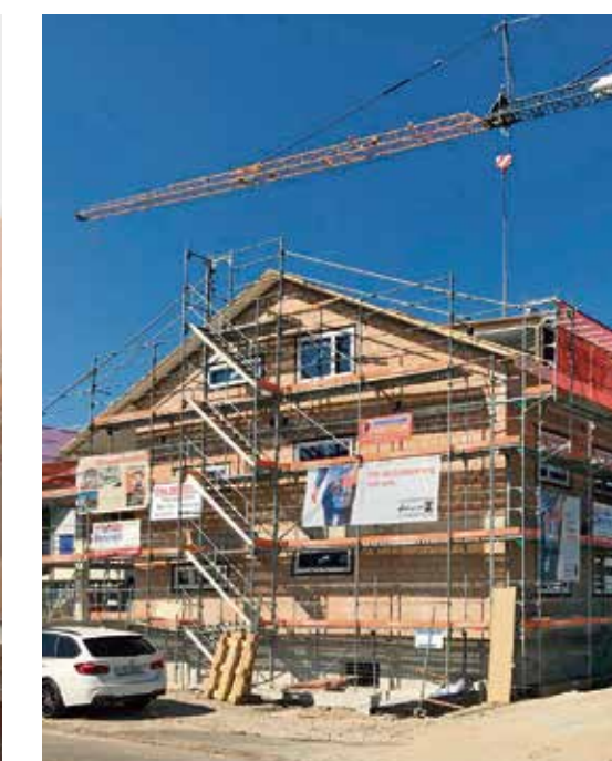
Mehrfamilienhaus Dorfstrasse, Ettenhausen
